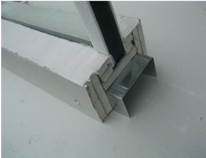
Leichte Trennbauwand 125mm stark
